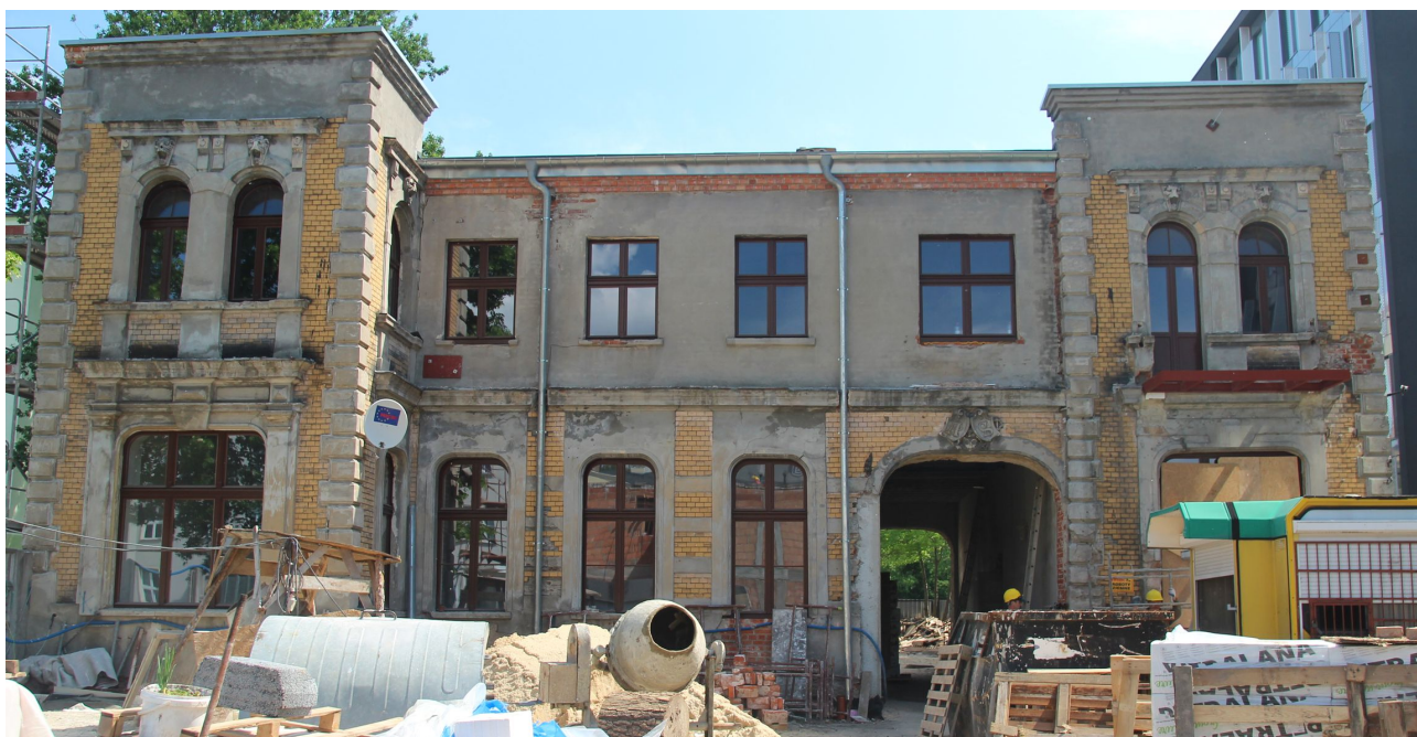
Fot . 1 Stan zachowania elewacji z okładziną klinkierową
